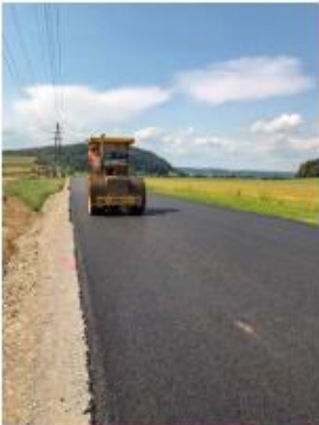
Damit der Verkehr weiterhin fliessen kann, musste eine temporäre Strasse erstellt werden. Nach dem Rückbau steht die Fläche wieder der Landwirtschaft zur Verfügung. Quelle: T&A
